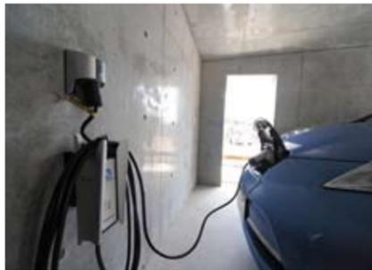
電気自動車は、ガレージに設置した電源から割安な夜間電力で充電。自動車から家に電気を送る制御装置は、メーカーの発売待ち。
